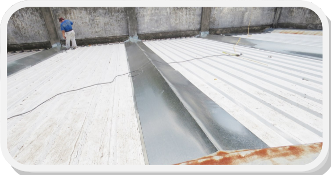
Trabajadores reparan techo de Auditorio
