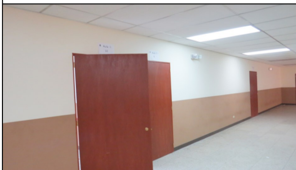
Instalación de nuevas puertas en Aulas
