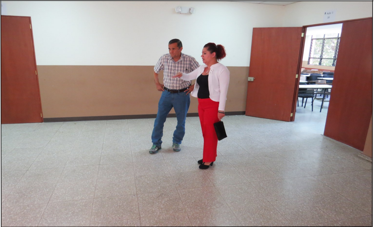
Decana de la Facultad y encargado de Servicios Generales observan reparaciones
