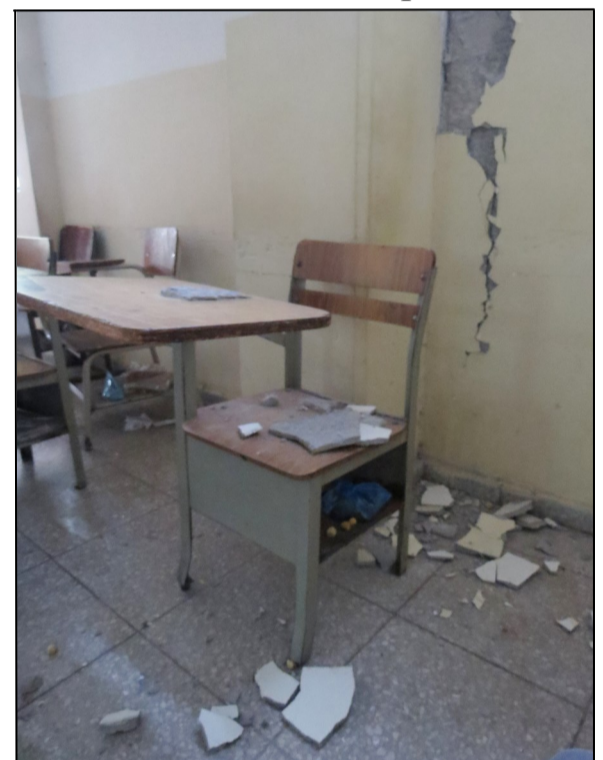
Parte de los daños ocasionados por enjambre sísmico del año 2017 en Edificio compartido
