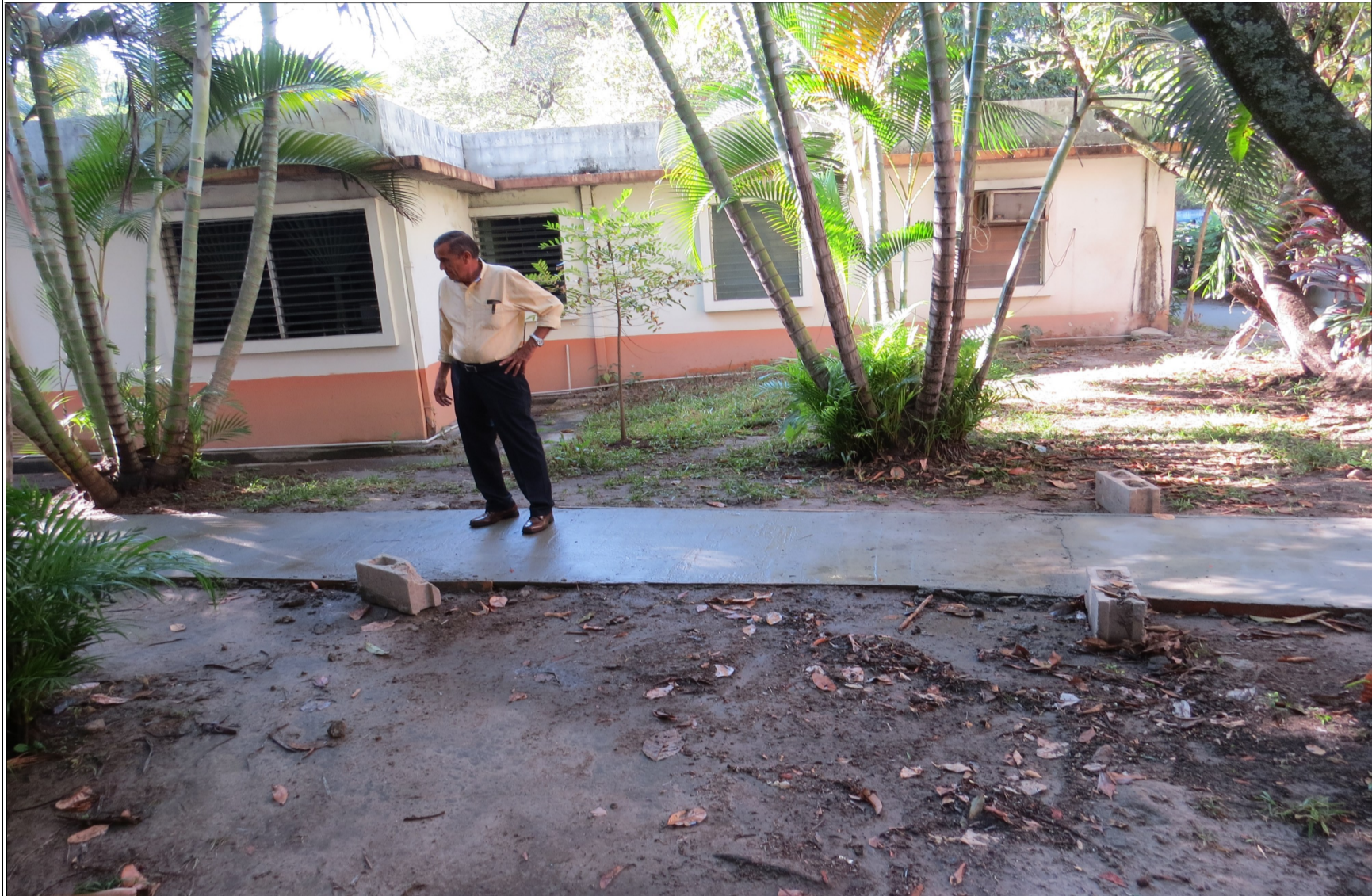
Sr. Serafín López, de la Unidad de Servicios Generales, observa trabajo de mejoramiento en acceso de la Escuela de Relaciones Internacionales hacia edificio compartido
